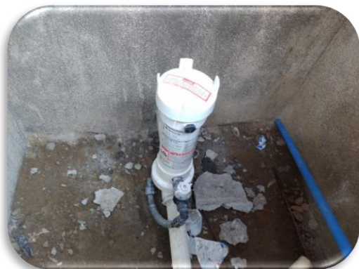
Imagen 6. Sistema de cloración en Caserío La Vega.
