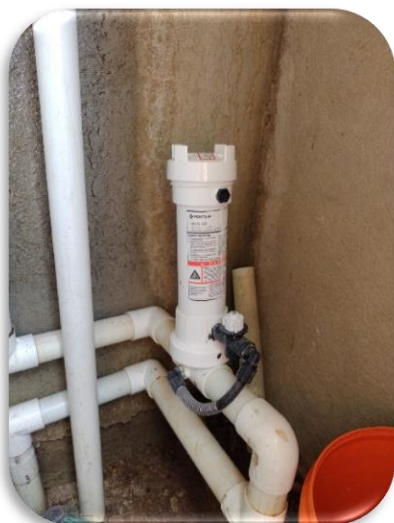
Imagen 6. Sistema de cloración en Caserío La Vega.
